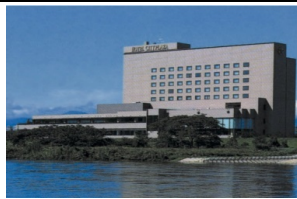
ホテルシティプラザ北上外観
