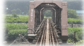
山形鉄道最上川橋梁（荒砥-四季の郷間）
