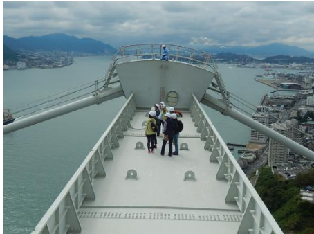
関門橋主塔上部へ塔頂(イメージ)
