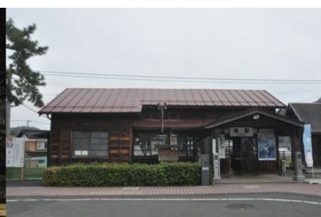
木造駅舎(隼駅)
